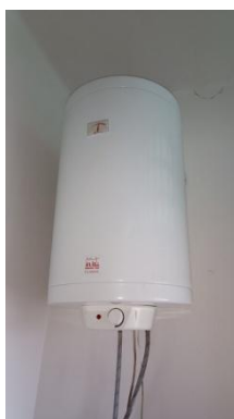
Obrázok 14. Elektrické zásobníkové ohrievače
